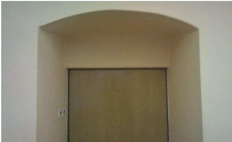
Obr. 19 Fotografie reálného vchodu (pohled zevnitř učebny)
